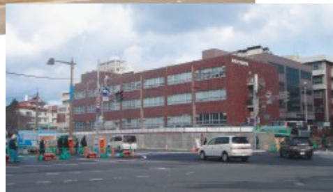
現在進行中の工事の様子
