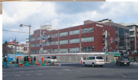
現在進行中の工事の様子
