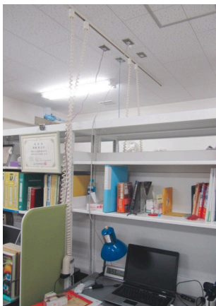
写真1 天井に設置した電源とLANの開口部。ケーブルを床に這わせることなく、個々のパソコンとすっきり接続することができました。
