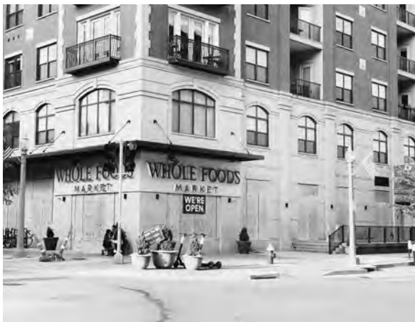
Black lives matterの暴動対策で、スーパーの窓ガラスに木板が打ち付けられている
